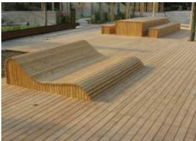
Илл. 1.1.14. ПРИМЕРЫ ПРИМЕНЕНИЯ ТЕРРАСНОЙ ДОСКИ ИЗ ДПК В ОБЩЕСТВЕННЫХ ПРОСТРАНСТВАХ
